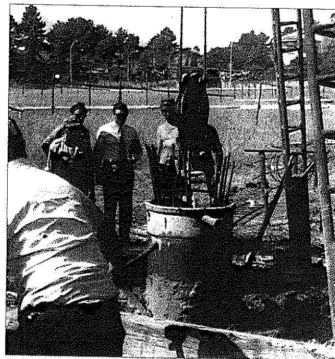
1977 - Lavoro su un palo di fondazione
